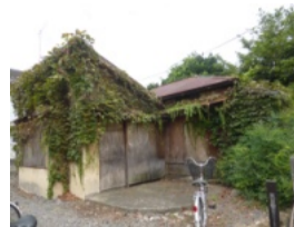
市内の空き家
