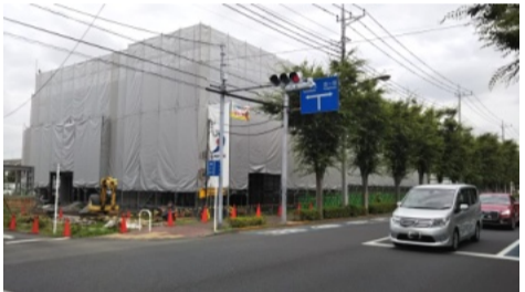
建築工事が進む、いなげや小金井東町店(仮称)。東大通り沿いに立地し、車での便も良い
