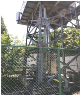
井戸。工事期間中は閉鎖される 庁舎建設予定地にある災害対策用
