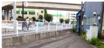
新庁舎等の建設予定地の広範囲が浸水予想区域(写真はリサイクル事業所付近の段差)
