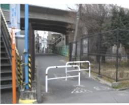
車両進入路として整備予定の市道626号線。現在は歩行者専用道路
